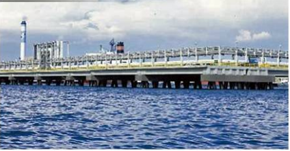
FPC Mai-Liao 台塑石化 麥寮 鋼管樁
