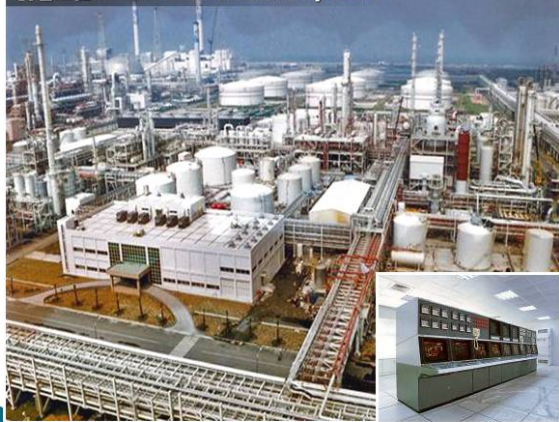
統包工程 Construction Turn-Key Base
