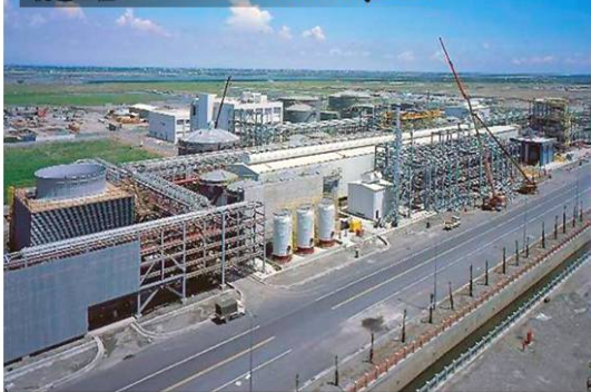
統包工程 Construction Turn-Key Base
